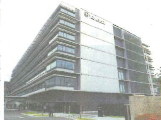
完成したヤマハの新研究・開発棟＝いずれも浜松市中区中沢町で
